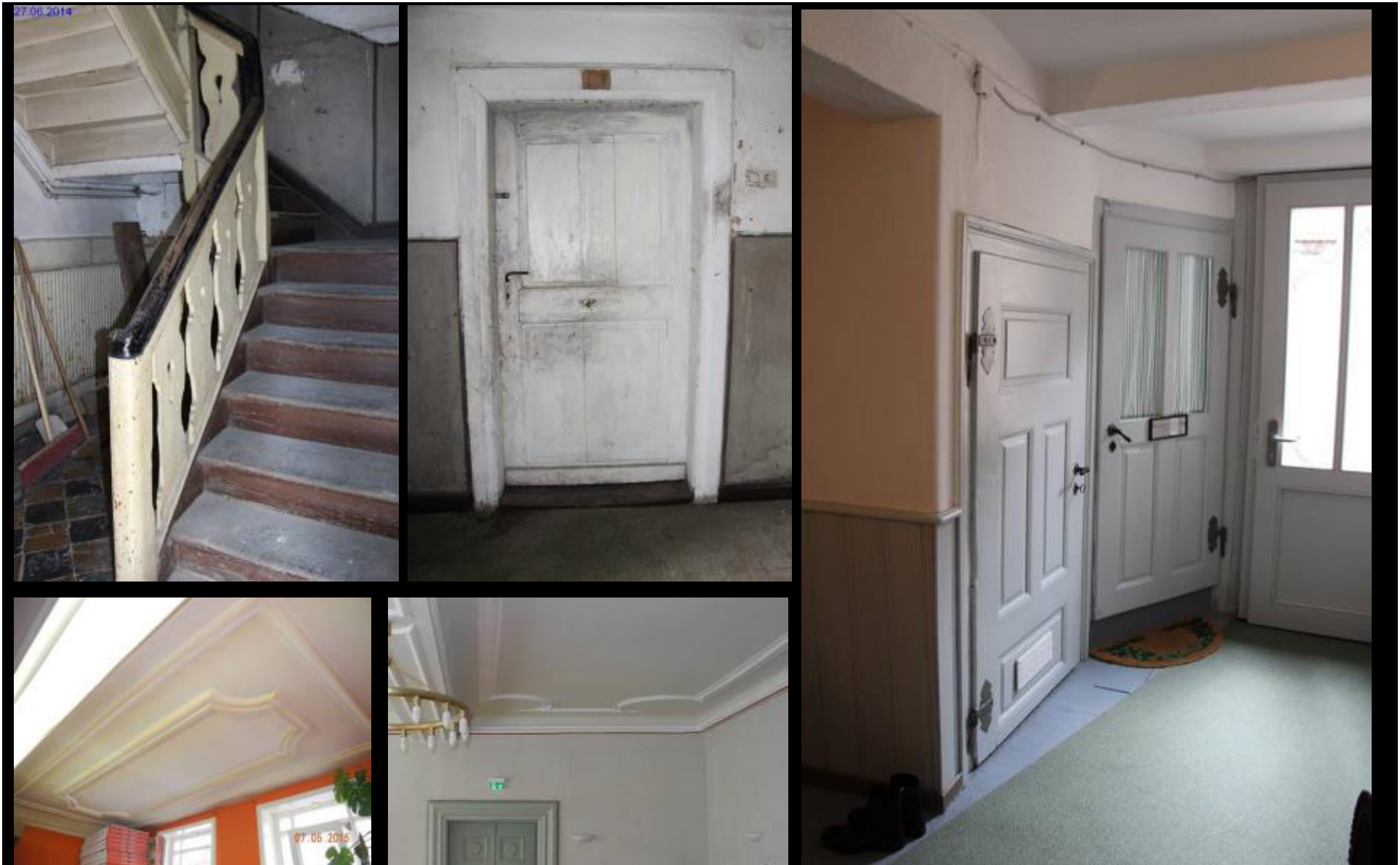
Wandfeste historische Ausstattungen: Treppen, Türen, Wandverkleidungen, Stuckdecken usw.
